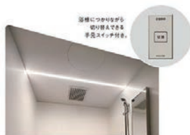
フラットライン照明
