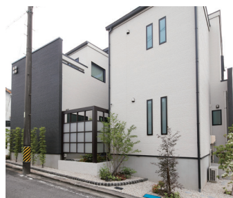
北東側から見る外観。見る角度によって形が違って見えるようデザインされている
